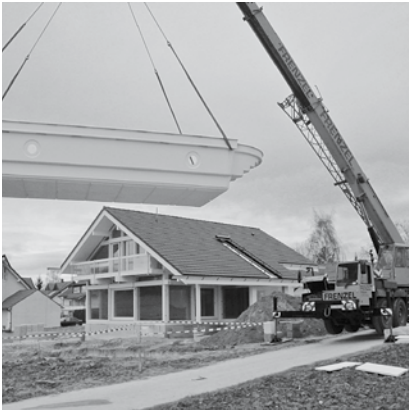
Einbringung per Kran
